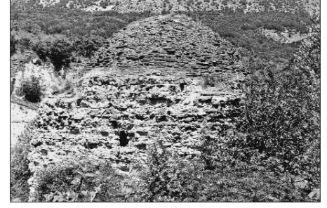
Zeytinlik Aşağı Türbe'nin batı cephesi
